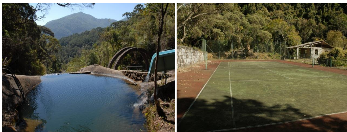
Figura 28 Da esquerda para a direita, piscina natural e quadra de tênis e estrutura de apoio inacabada.
