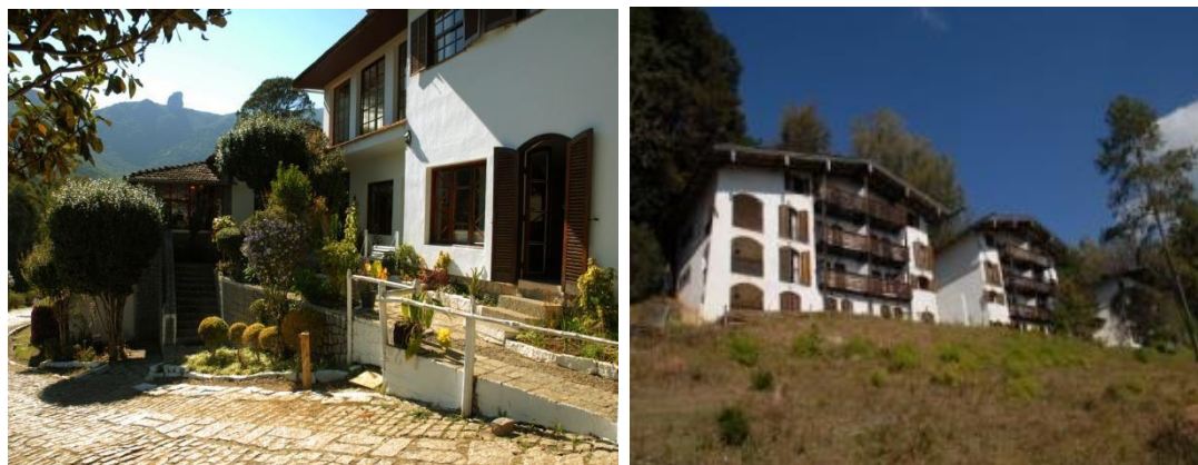
Figura 27 Estrutura física da Fazenda Pinhão Assado. Da esquerda para a direita, prédio principal (recepção, sala, restaurante, cozinha, auditório e banheiros), e 3 blocos de suítes do antigo Hotel Casa Alpina.
